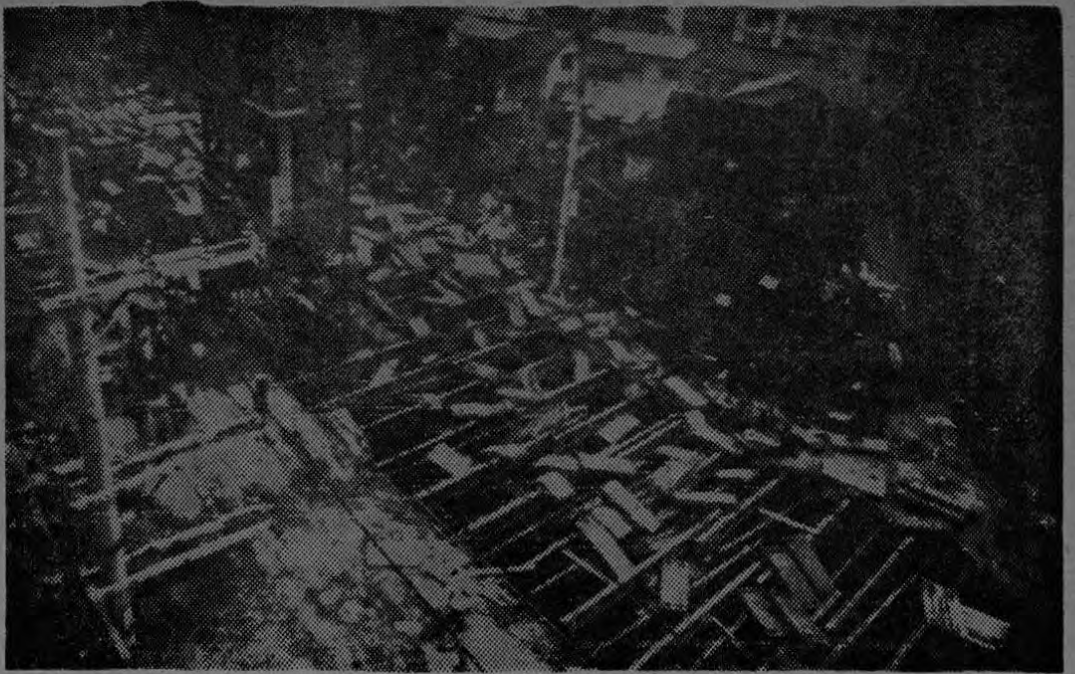
OSAKA, Japón, Abril, 9 (AP). — Bloques de cemento cada uno de los cuales pesa media tonelada, cubren la carretera en una prolongación del ferrocarril subterráneo urbano, donde
